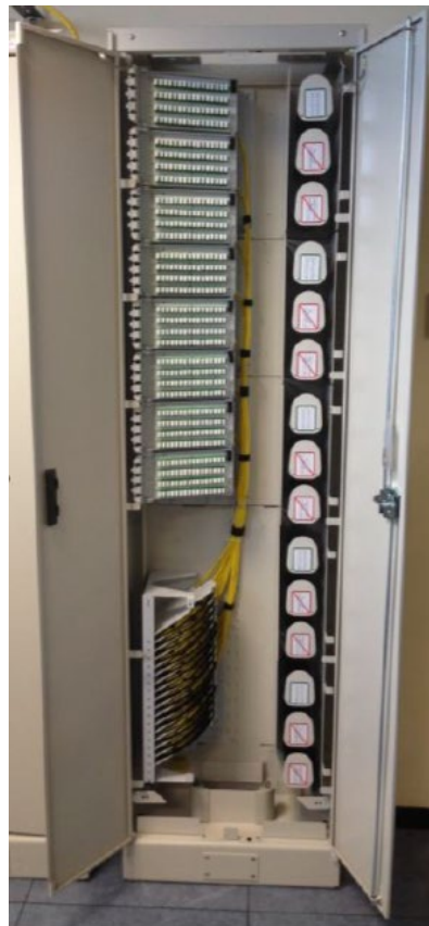
Figura 5 – Ejemplo de repartidor OMX 512 HD
