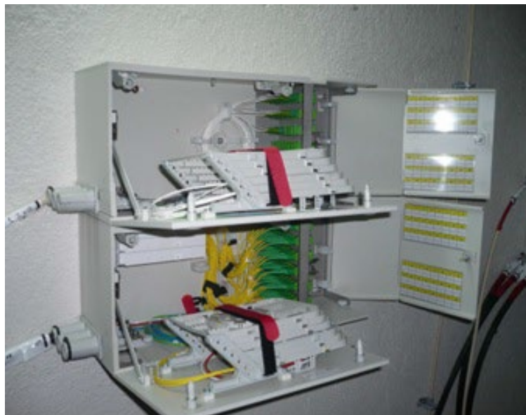
Figura 62 – Ejemplo de cajas MOBI-48-CU y MOBI-48-OP en cascada
