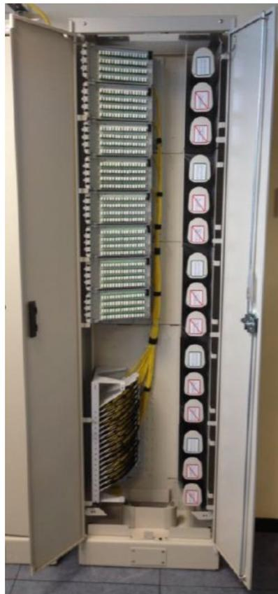
Figura 5 – Ejemplo de repartidor OMX 512 HD
