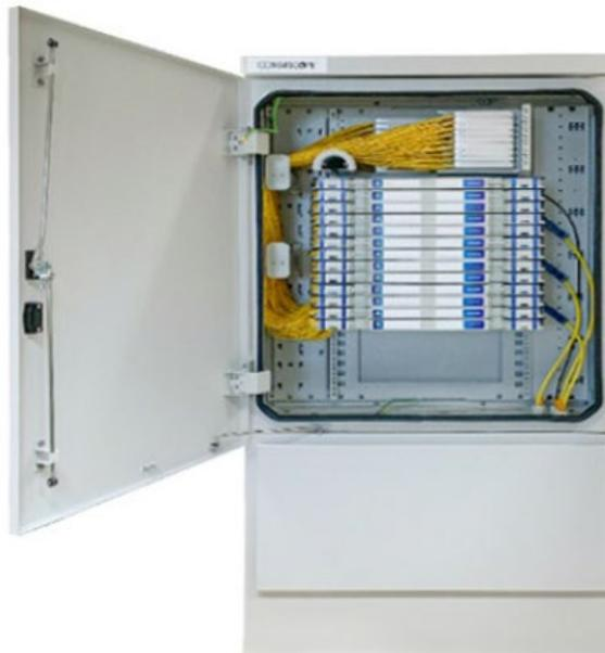
Figura 27 – Ejemplo de armario repartidor de FO de exterior
