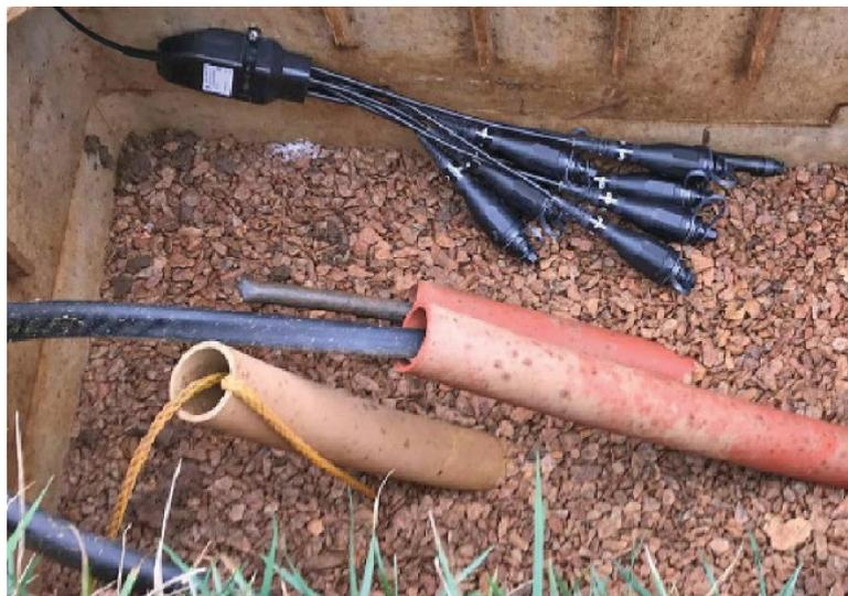
Figura 41 – Ejemplo de despliegue de una caja FST en arqueta
